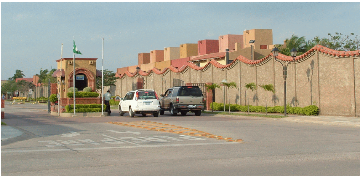
Foto 3: Entrada a la urbanización cerrada “La Hacienda”, Santa Cruz
