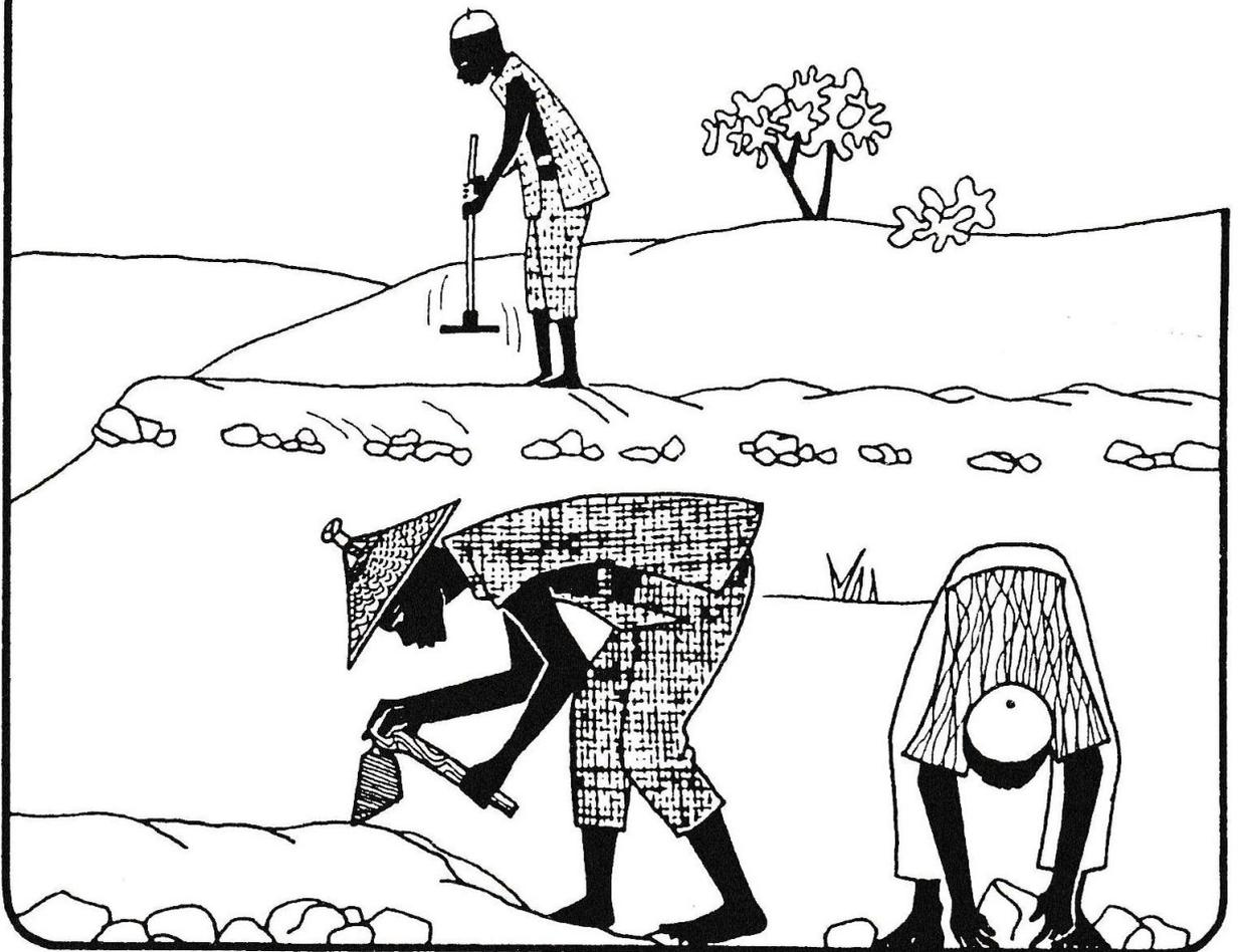
Abb. 2 Die Anlagen von kleinen Dämmen zum Erosionsschutz. Quelle: Didaktisches Schulungsmaterial GRAAP, Burkina Faso.
